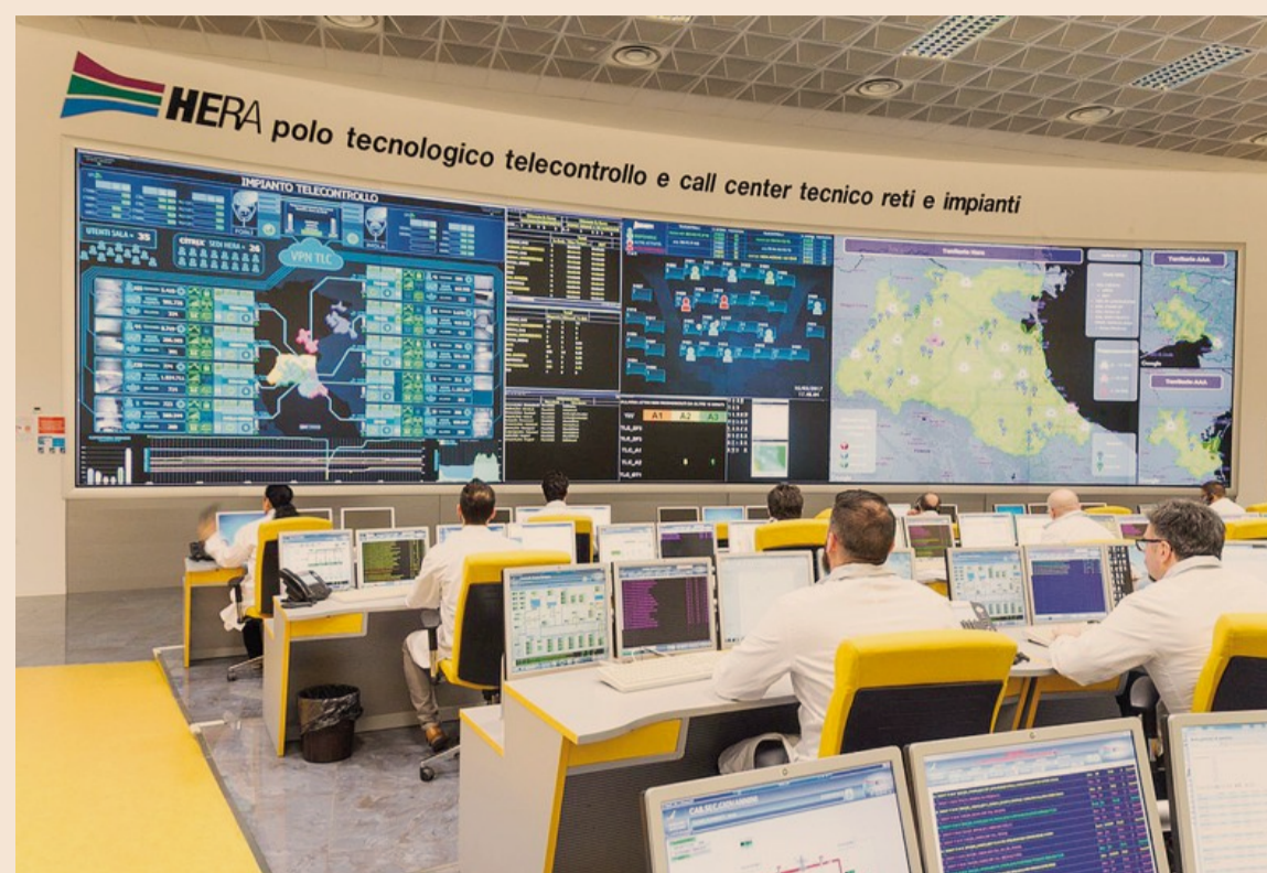
Telecontrollo. Il polo tecnologico a Forlì del gruppo Hera controlla da remoto 67 mila km di reti idriche, gas e teleriscaldamento del gruppo e 4 mila impianti
